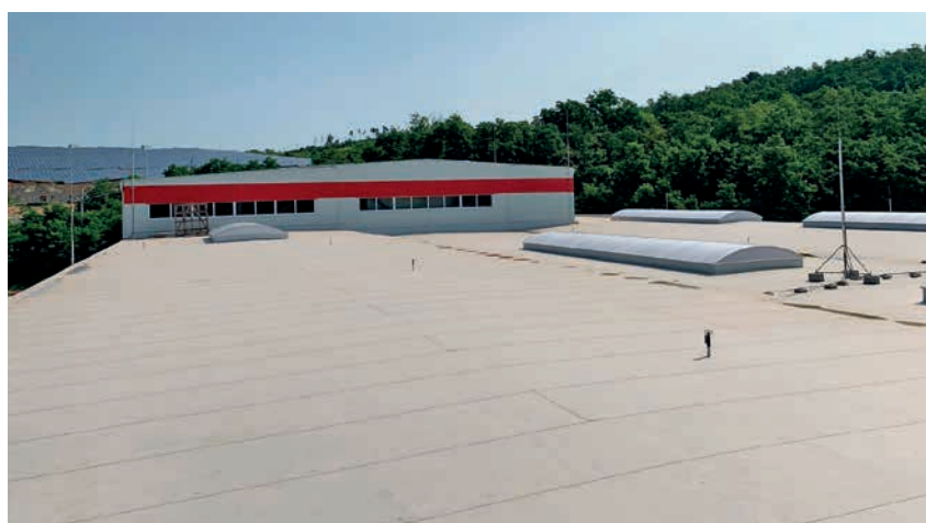
Střecha objektu během instalace jímací soustavy
