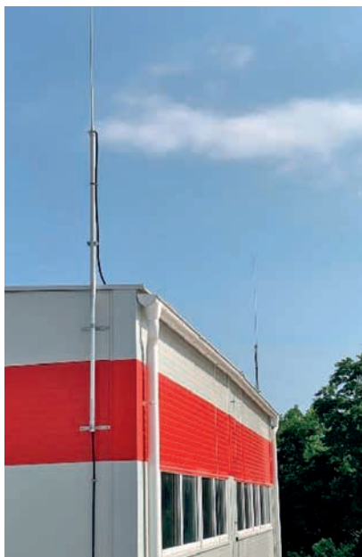
Podpůrné trubky instalované na stěnách a na střeše budovy
