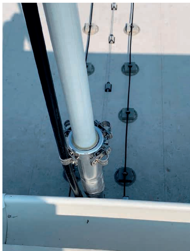
Připojení vodiče HVI long na podpůrnou trubku a pohled na správně osazenou PA svorku
