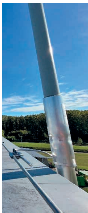
Připojení vodiče HVI long na podpůrnou trubku a pohled na správně osazenou PA svorku
