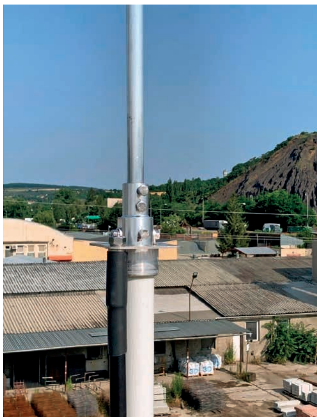
Připojení vodiče HVI long na podpůrnou trubku a pohled na správně osazenou PA svorku
