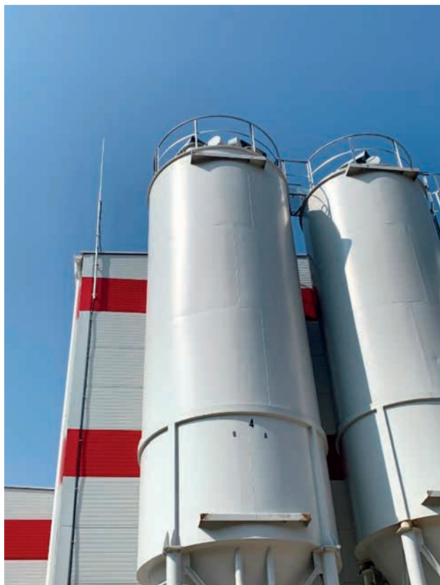
Svody vodičem HVI long přiznány na plášti budovy a ukončeny na zaváděcí tyči se zkušební svorkou
