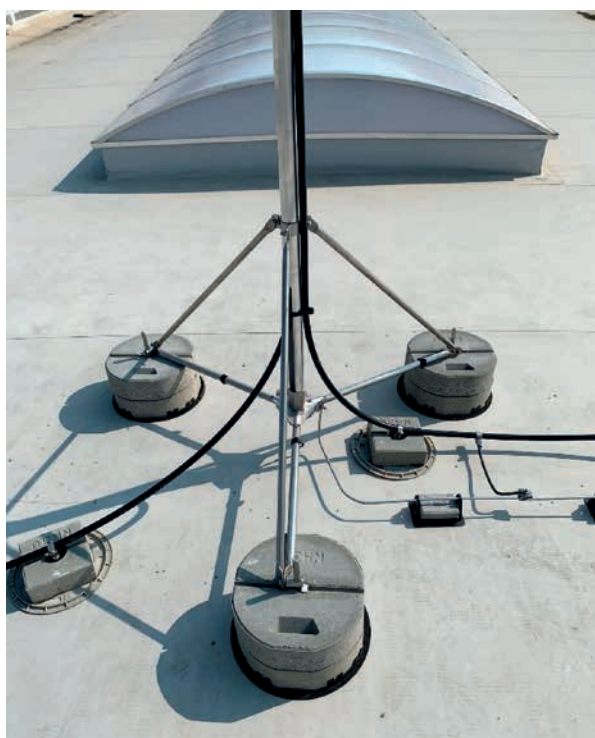
Detail provedení PA pospojování podpůrných trubek
