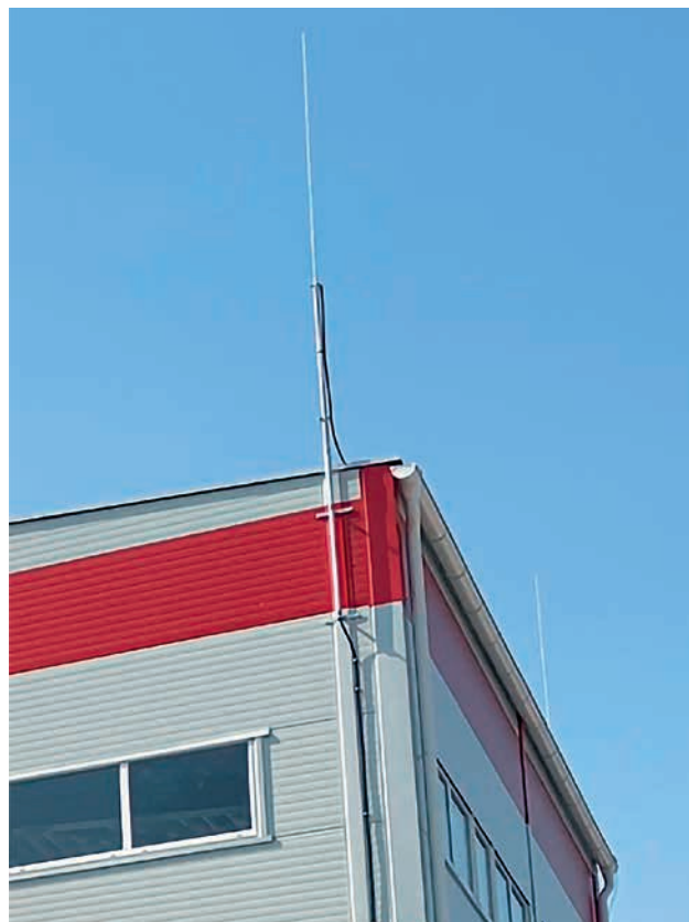
Svody vodičem HVI long přiznány na plášti budovy a ukončeny na zaváděcí tyči se zkušební svorkou
