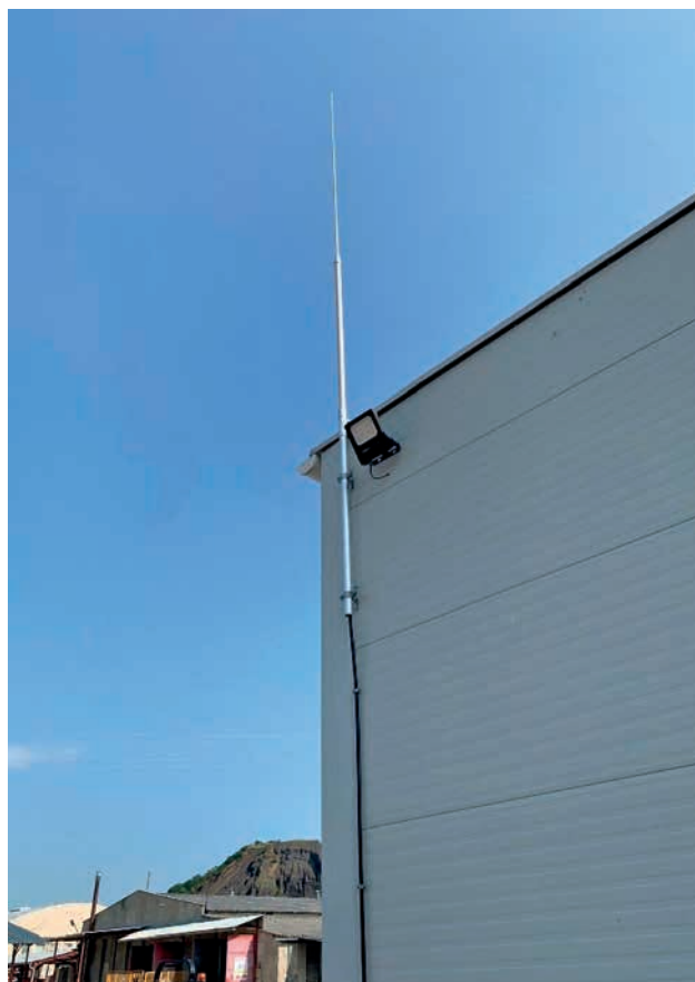
Podpůrné trubky uchyceny na stěnách budovy za pomoci držáků na stěnu s nastavitelnou délkou odstupe od stěny
