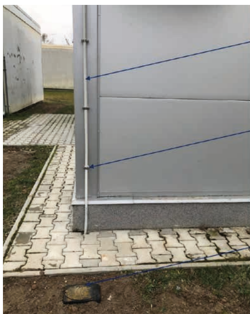
Obr. 7. Detail kotvení vodiče HVI long a provedení zemní litinové krabice
