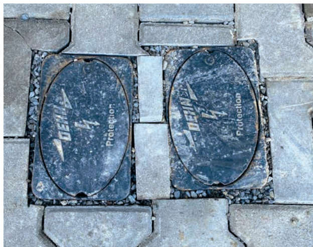
Detail zemní litinové krabice se zkušební svorkou
