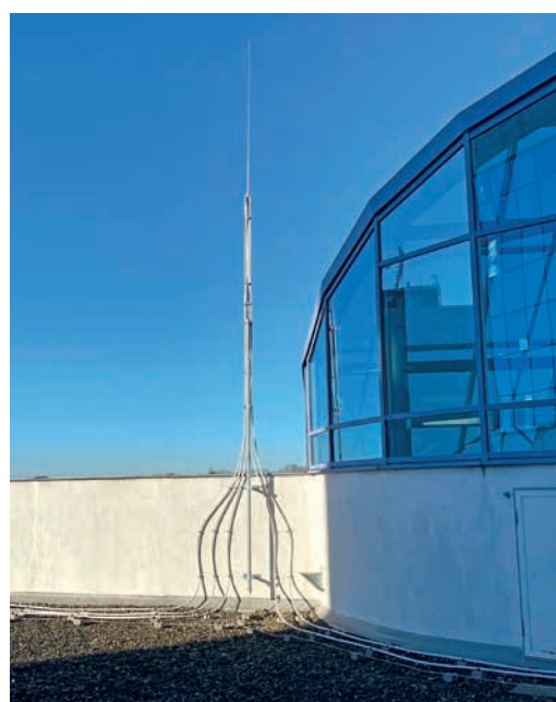
Detail podpůrné trubky na nižší části budovy
