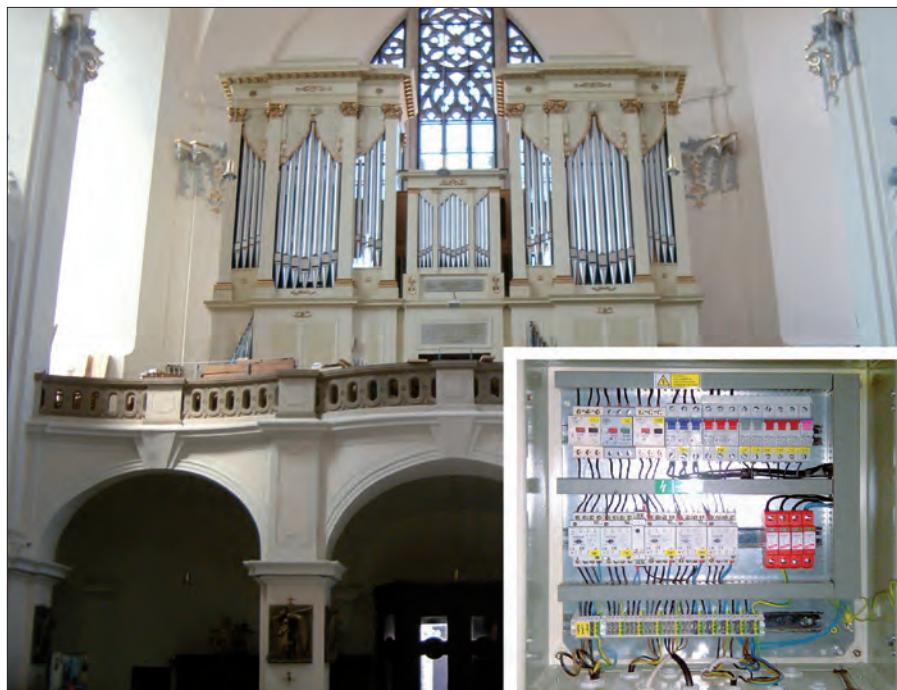
Obr. 4. Podružný rozváděč varhan – svodič přepětí SPD typu 2
