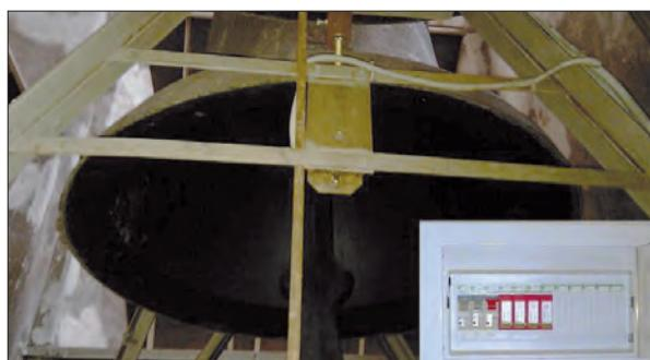
Obr. 5. Podružný rozváděč zvonů – svodič přepětí SPD typu 2
