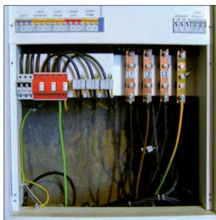
Obr. 3. Hlavní rozváděč – svodič SPD typu 1
